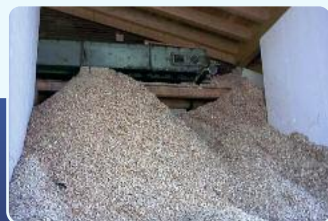
Centrale di cogenerazione a biomassa di Asiago (VI)
