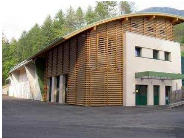
Fig. 1: Centrale trigenerazione costruito
