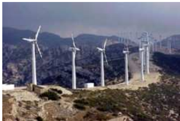
Fig.1: parco eolico costruito
